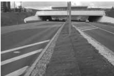
**Abbildung 7: Moosmatten wurden erstmalig an der Autobahn 562 in Bonn zur Begrünung von Mittelstreifen eingesetzt.** Sie bieten dort eine pflegeleichte Bepflanzung. Durch die Moosblättchen wird die biologische Oberfläche um den Faktor 30 vergrößert.
